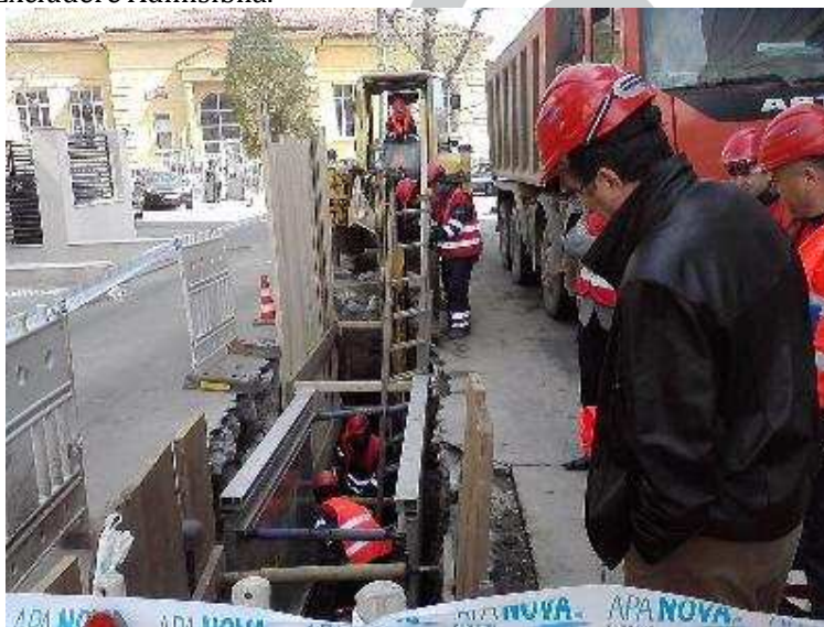
Inlocuire conducta de canalizare in urma prabusirii acesteia (sector 4)
