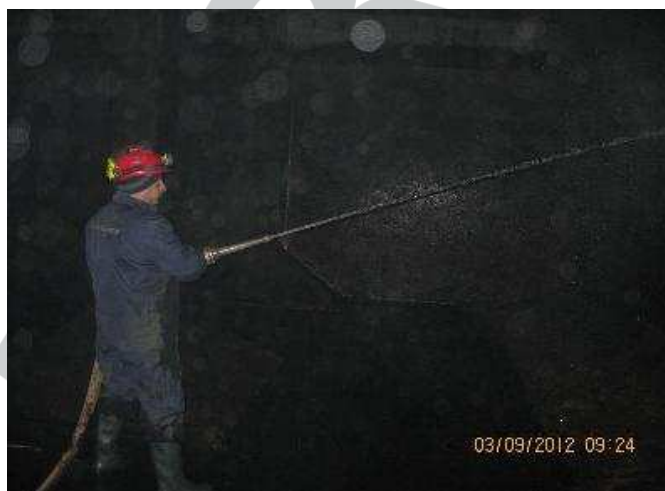
Spalare Rezervor (35 000mc) la Statia de Pompare Sud
